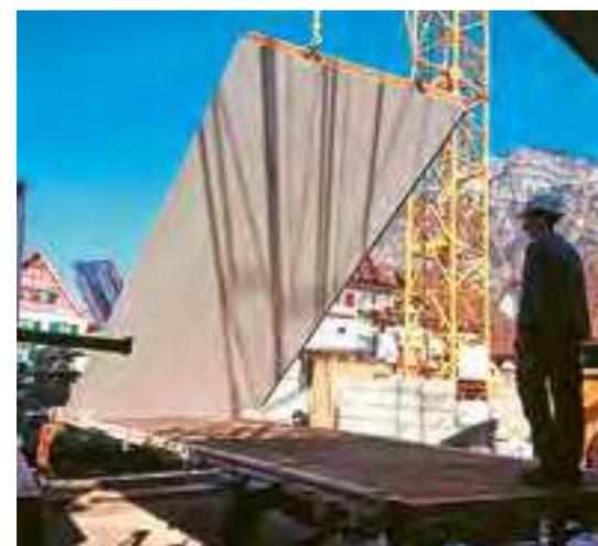
Massive Holzwände: Was in der Produktionshalle der Edi Willi AG vorbereitet wird, wird schliesslich per Kran in die Höhe gehievt.
